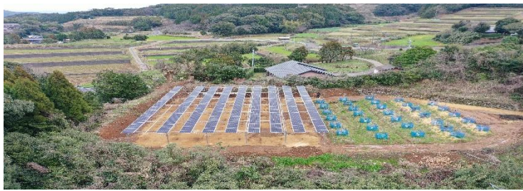
営農型太陽光（49kW）によるアボカド栽培を実施
