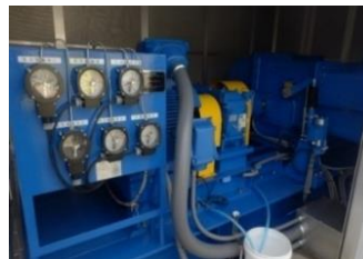
小水力発電設備の設置(御所浄水場)
