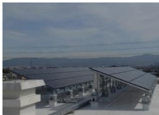
太陽光発電設備の設置(郡山総合庁舎)
