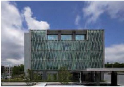
向日市役所本館
