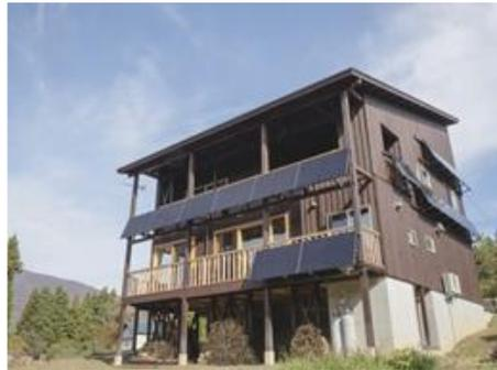
そこで、妙高市と同じく豪雪地である長野県飯山市・野沢温泉村において住宅等の軒下壁面に設置され、商用化されている「雪国型太陽光発電設備」を公共施設に導入し、市民や市内事業所に効果等を発信するとともに、住宅や事業所等への雪国型太陽光発電設備の設置に対して補助を行い、普及拡大につなげる。
