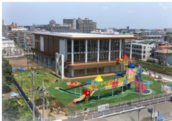
ピークカット機能など先進的な蓄電池システム (近隣市メーカー製)を導入したポラリス
