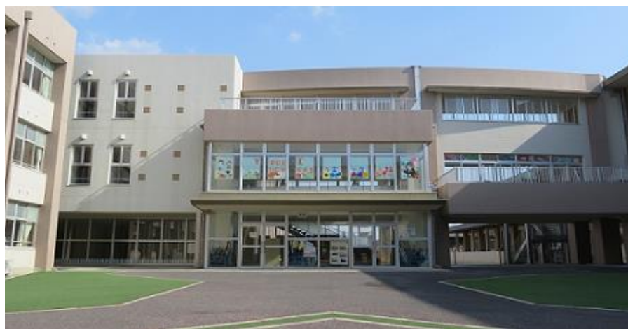
太陽光発電設備を導入予定の小中一貫校
