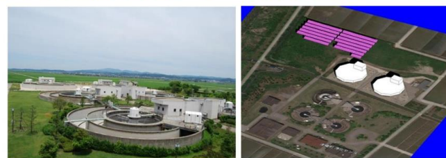
町下水道浄化センター (年間想定発電量557MWh)
