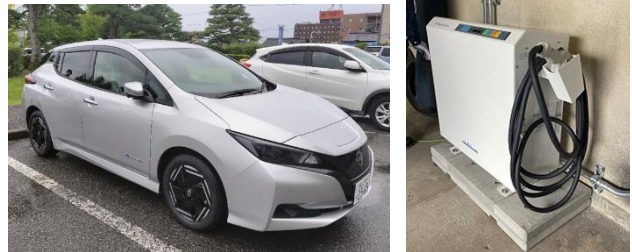
図9. 公用車へのEV車導入・充電設備設置
