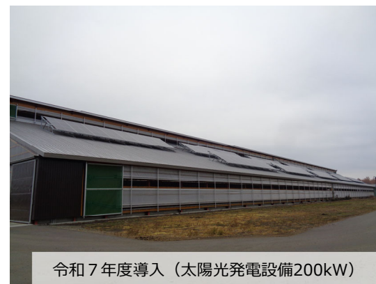
交付金を活用して酪農家に導入された設備
