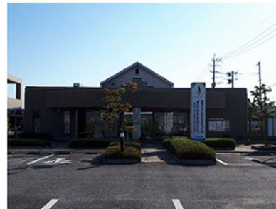
【筑邦市民センター】 (Nearly ZEB) ※R9年度完成予定
