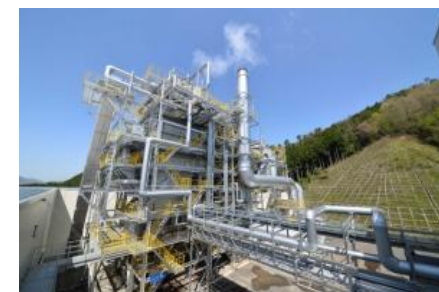
真庭バイオマス発電所
