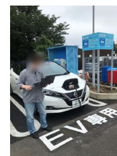
顧客向けEVパワーステーション
