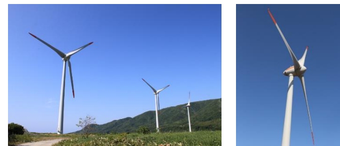
寿都町 風力発電施設
