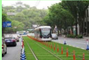
軌道敷緑化の整備 (熊本県熊本市)
