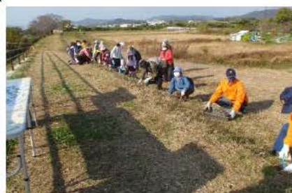
河川改修後の新設法面に半自然草地を再
