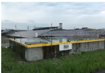
工場内の貯水槽
