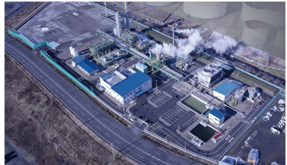
苫小牧CCS実証試験センター
